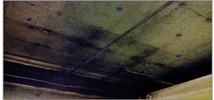
A kormos levegő, a savas kipufogógázok megtámadhatják a nem pontosan erre a célra kifejlesztett szigeteléseket
