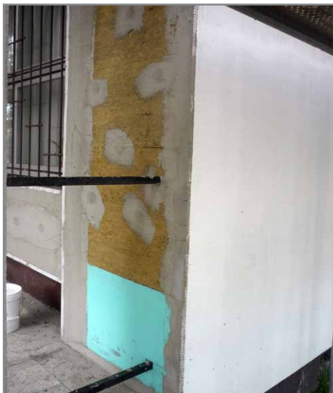
A Nobasil FKD S ásványgyapattal a hő- és hangszigetelés is lényegesen javult
