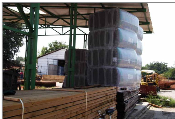
TP 435 B üvegyapot bálák a beépítés előtt és a fafonatos zajvédő falba építés során
