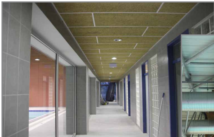
Esztétikus hangelnyelő felületek műszaki előnyökkel (Kivitelező: Fodor Építőipari és Szolgáltató Kft.)
