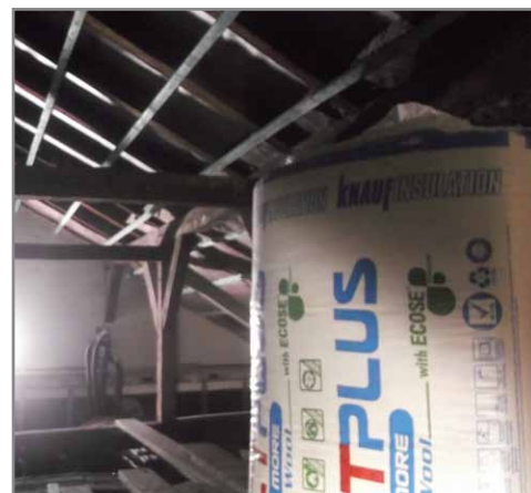
Első beépítésük az országban: Debrecen Református Kollégium. A kollégiumi épület felújítása során a magas tető kapott FactPlus® 037 hőszigetelést a szarufák között és alatt
