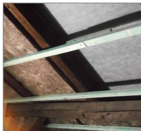
Első beépítésük az országban: Debrecen Református Kollégium. A kollégiumi épület felújítása során a magas tető kapott FactPlus® 037 hőszigetelést a szarufák között és alatt
