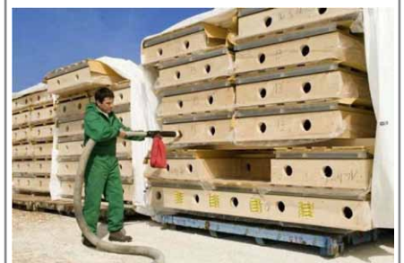
Előregyártott falak kitöltése
