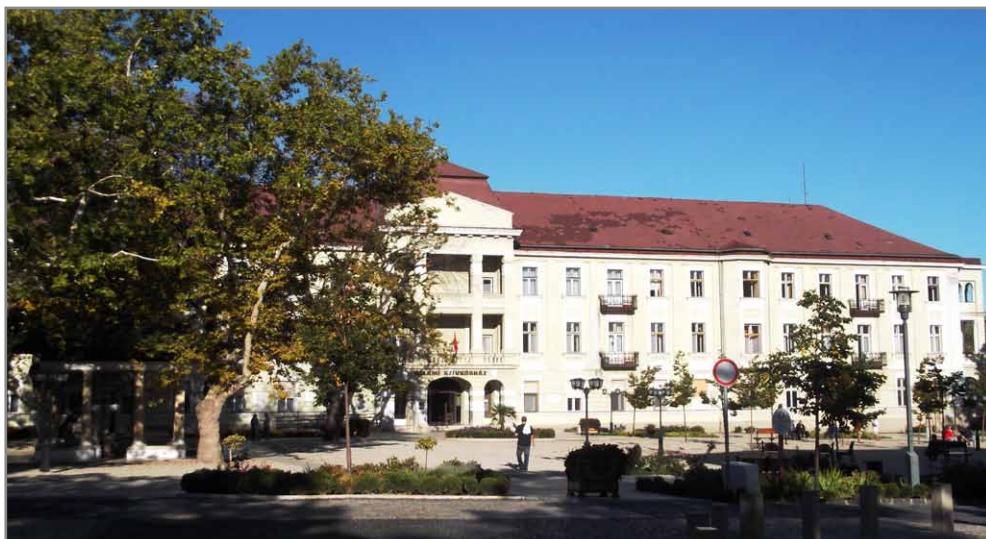
Balatonfüredi Szívkörház, energetikai felújítás (Kivitelező: Hunép-Capital-Bau Kft.)
